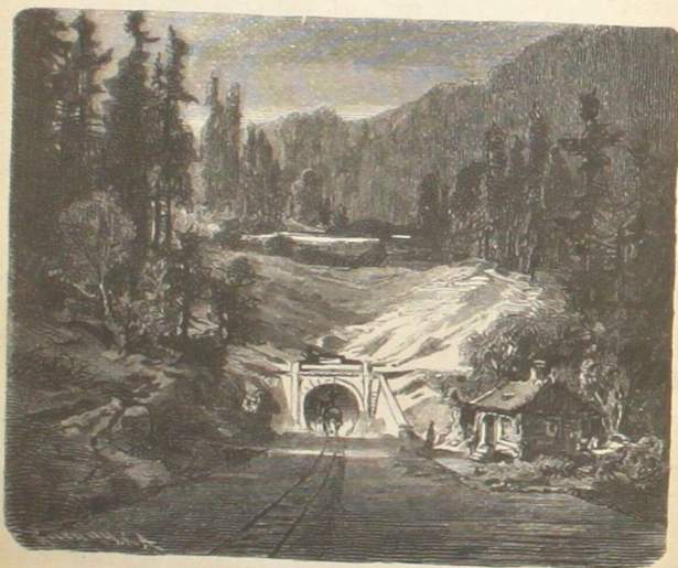
„PORTAL DES SPITZBERG-TUNNELS.“
